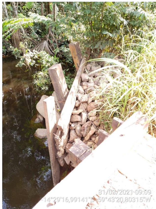
Ponte de madeira sobre a Vazão 1 do Rio Galera – 18,00m x 5,00m
