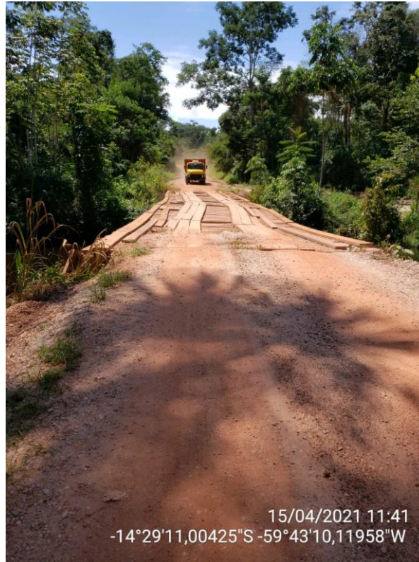
Ponte de madeira sobre o Rio Galera – 32,00m x 5,00m
