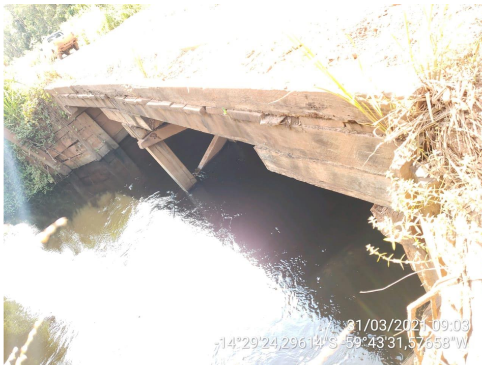
Ponte de madeira sobre a Vazão 2 do Rio Galera – 12,00m x 5,00m
