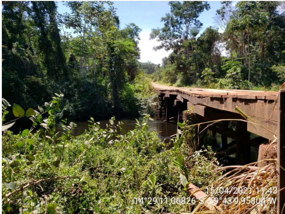
Ponte de madeira sobre o Rio Galera – 32,00m x 5,00m
