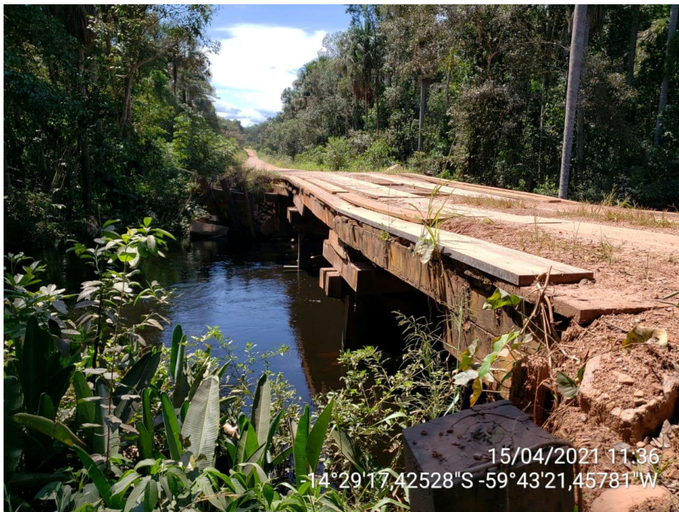
Ponte de madeira sobre a Vazão 1 do Rio Galera – 18,00m x 5,00m
